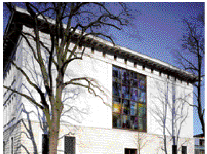
Außenansicht der von Rothkegel realisierten sechs mal acht Meter großen Glasfassade der LZB-Niederlassung in Meiningen.
