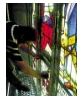
Oben: Letzte sorgfältige Handgriffe beim Wiedereinbau von restaurierten Glasmalereifeldern in der Ev. Stadtpfarrkirche St. Andreas in Weißenburg
