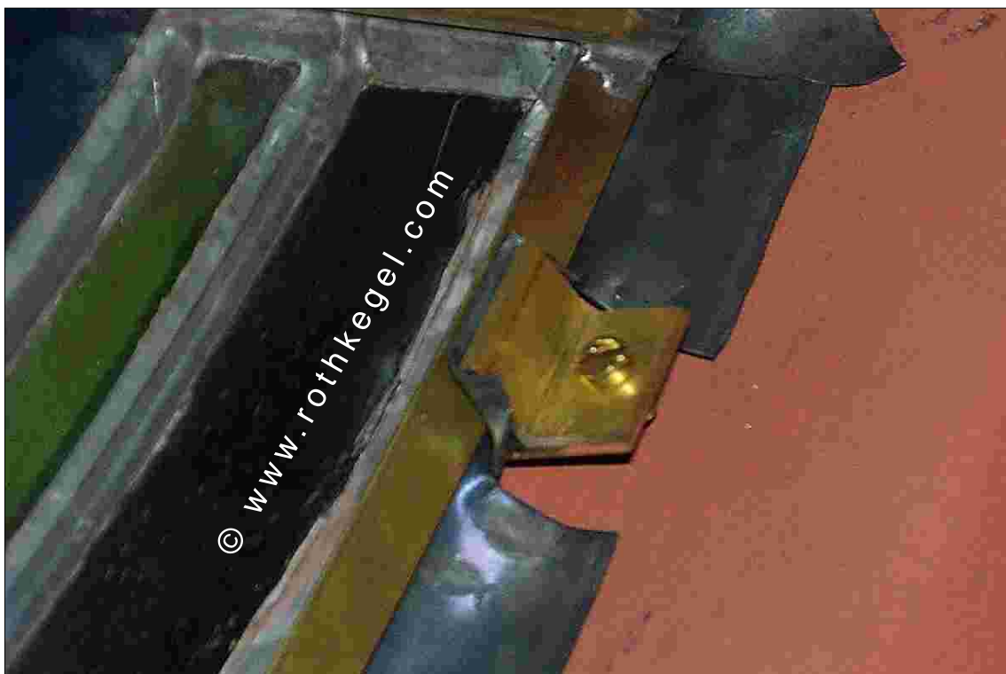
Maßwerkhalter aus Messing, diese halten ebenfass die Schutzverglasung und sind jeweils mit nur einer Lohborung im Falzgrund fixiert, die Befestigung wird mechanisch mit einer gegen Lockerung gesicherter Schraube ausgeführt
