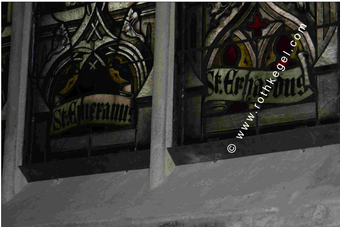
Fußpunkt Situation - Verkleidung des unteren Lichtschlitzes
