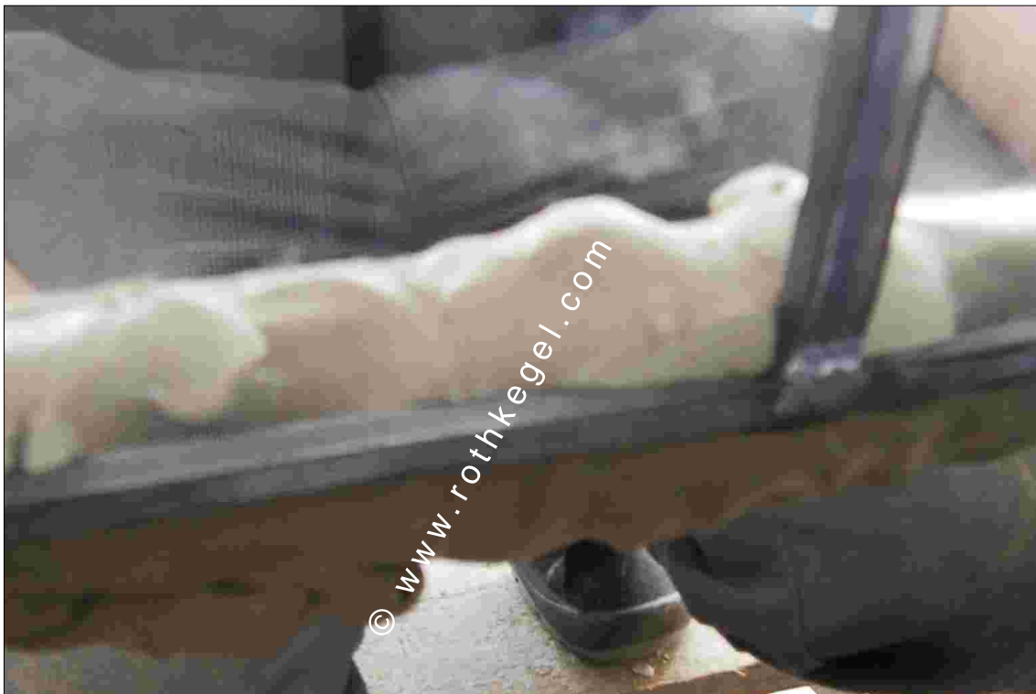
Vollsatte Verkitzung der Quereisen und direkt eingelegte Schutzverglasung; zum Stein ist mit Haarkalk genau so zu verfahren
