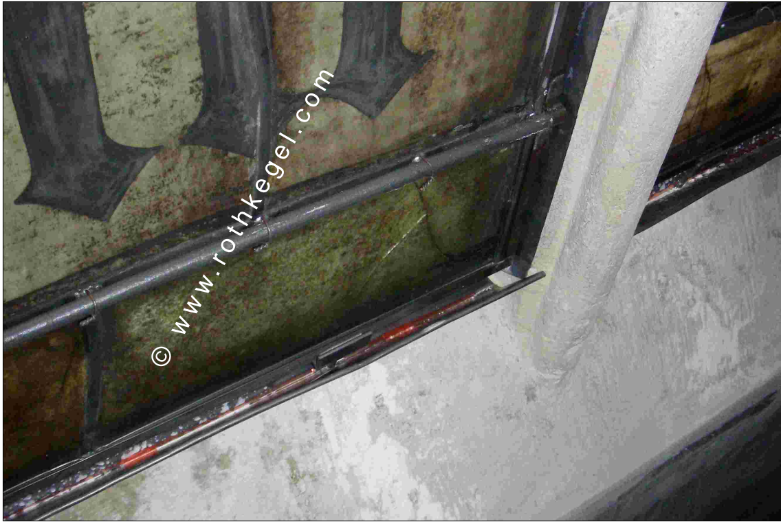
Fußpunkt Situation - Verkleidung des unteren Lichtschlitzes
